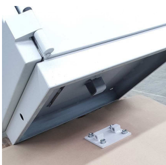
5. Til en plaats de kluis over de verankeringsplaat
